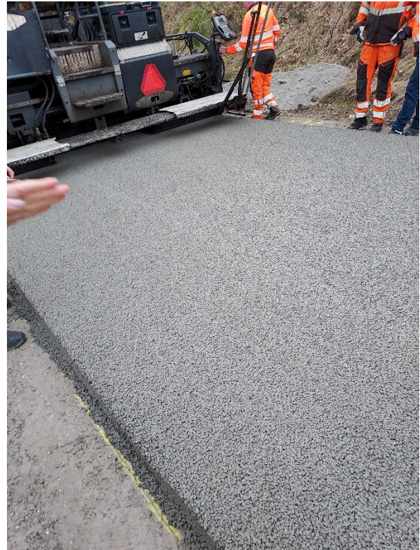
UNI-Drænbeton E08. Unicon Viborg - udstøbning af kørevej med asfaldudlægger.
