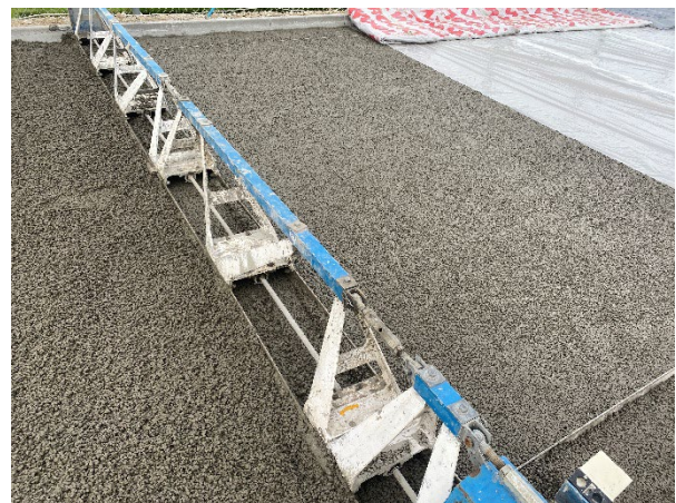
UNI-Drænbeton E08. Permeabel betonbelægning til P-plads. Udlægning med bjælkevibrator.
