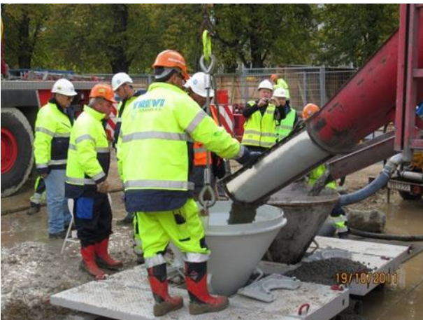
Foto: Støbning af panel gennem to tremmies.
