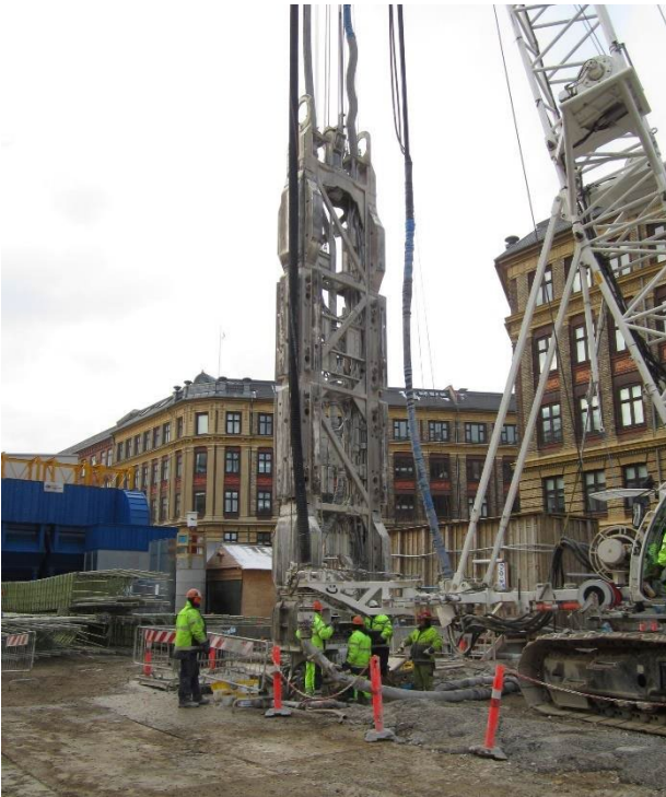
Foto: Hydromill, der fræser et panel ud i undergrunden.
